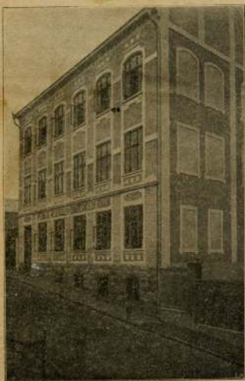
Internatul meseriașilor și comercianților români din Cernăuți.
